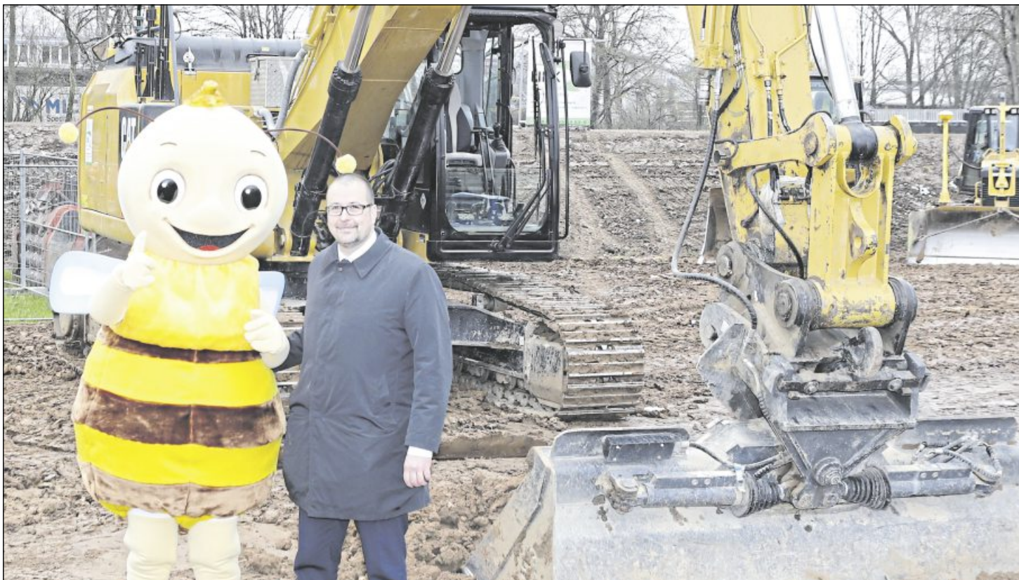
Gartenschau-Maskottchen Remsi und der Weinstädter OB Michael Scharmann beim offiziellen Baustart für den Remsstrand.
