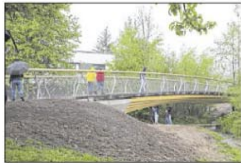
Die Urbacher Brücke.
